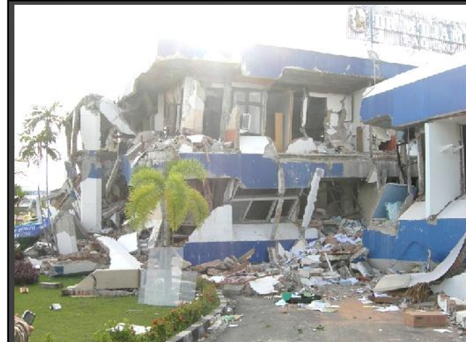
Pengalaman kerusakan gedung rumah sakit akibat gempa Padang tahun 2009
