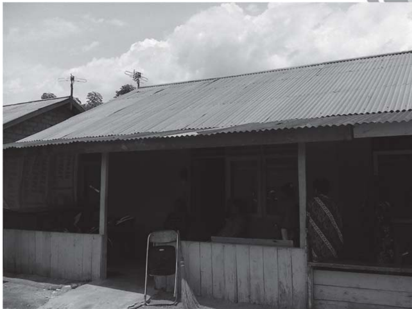
ID Bangunan C-131 Struktur Kayu 1 Lantai, Kategori Penggunaan : Hunian
