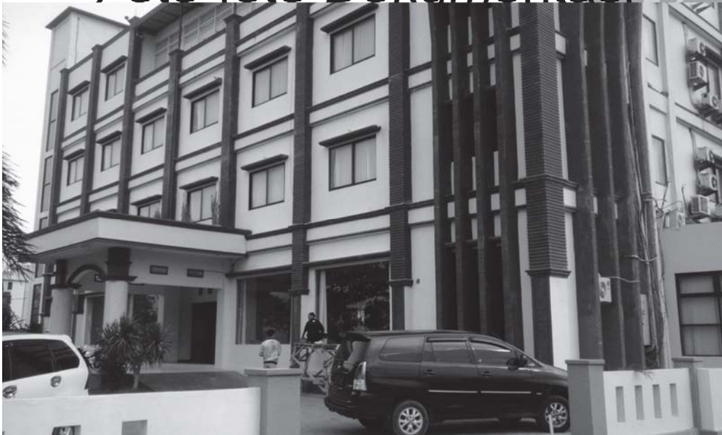
ID Bangunan A-007 Bangunan Beton Bertulang 4 Lantai, Kategori Penggunaan : Hotel
