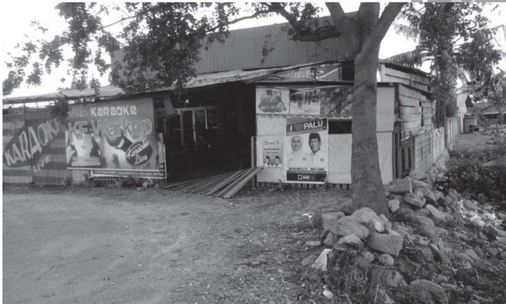
ID Bangunan B-103 Struktur Kayu 1 Lantai, Kategori Penggunaan : Komersil
