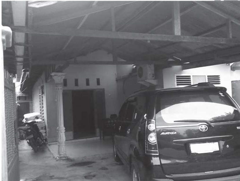
ID Bangunan C-005 Struktur Pasangan 1 Lantai, Kategori Penggunaan : Hunian
