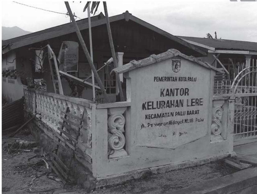
ID Bangunan B-088 Struktur Pasangan 1 Lantai, Kategori Penggunaan : Pemerintahan
