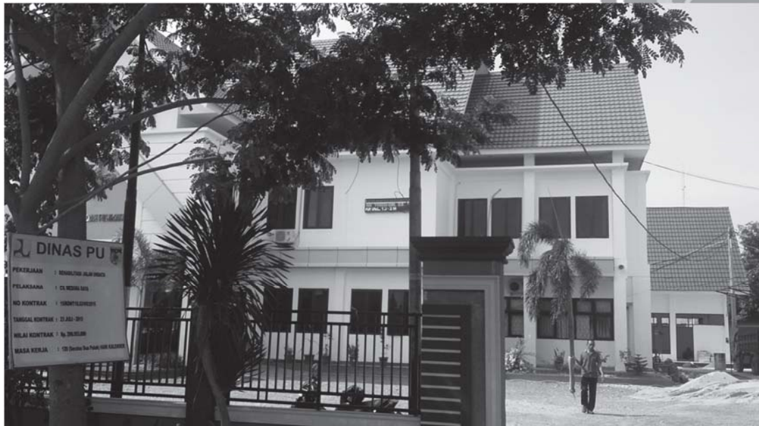
ID Bangunan A-032 Bangunan Beton Bertulang 2 Lantai, Kategori Penggunaan : Pemerintahan
