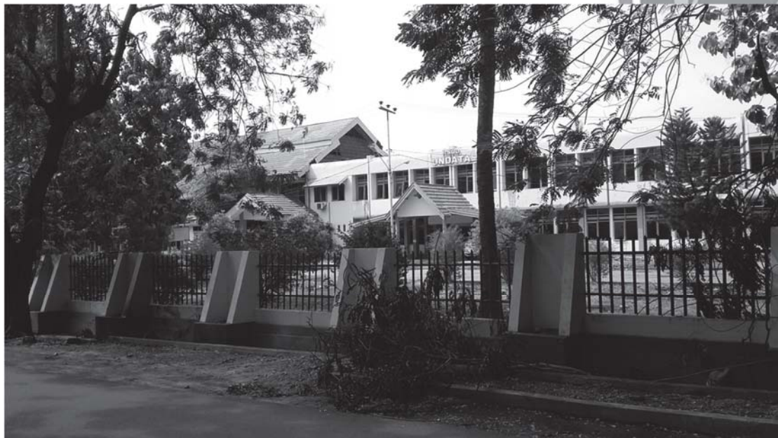
ID Bangunan A-030 Bangunan Beton Bertulang 2 Lantai, Kategori Penggunaan : Rumah Sakit
