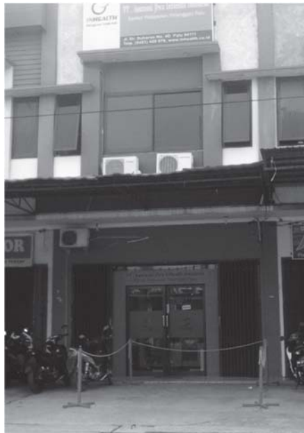
ID Bangunan B-003 Bangunan Beton Bertulang 2 Lantai, Kategori Penggunaan : Komersil
