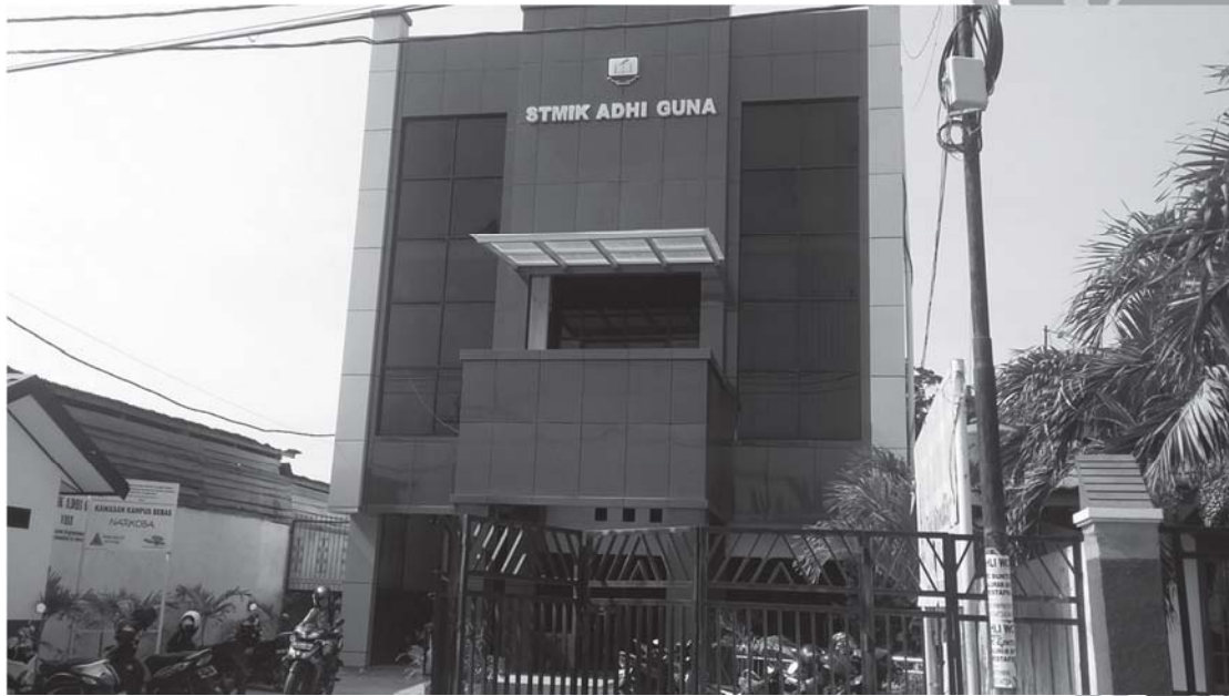
ID Bangunan A-033 Bangunan Beton Bertulang 3 Lantai, Kategori Penggunaan : Pendidikan
