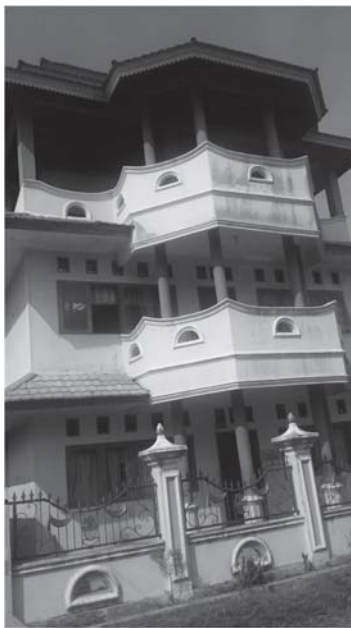
ID Bangunan A-067 Bangunan Beton Bertulang 3 Lantai, Kategori Penggunaan : Hunian
