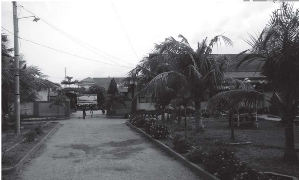
ID Bangunan B-126 Struktur Beton 2 Lantai, Kategori Penggunaan : Pendidikan
