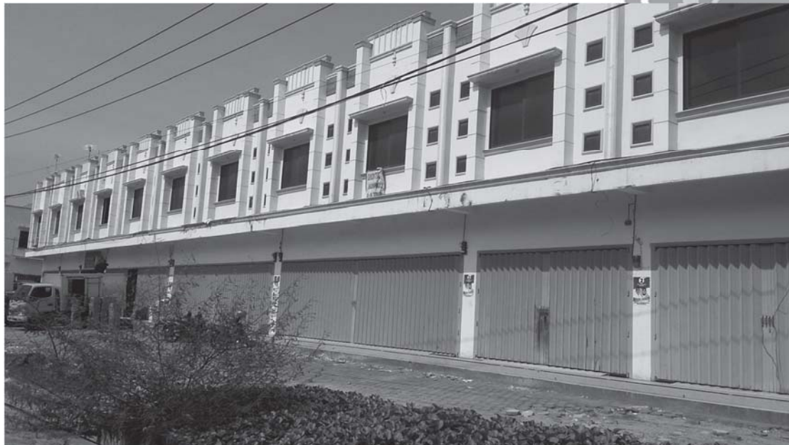
ID Bangunan A-034 Bangunan Beton Bertulang 2 Lantai, Kategori Penggunaan : Komersil
