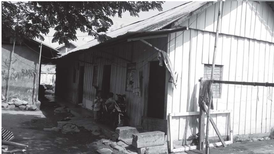
ID Bangunan A-014 Bahan Struktur Kayu 1 Lantai, Kategori Penggunaan : Hunian
