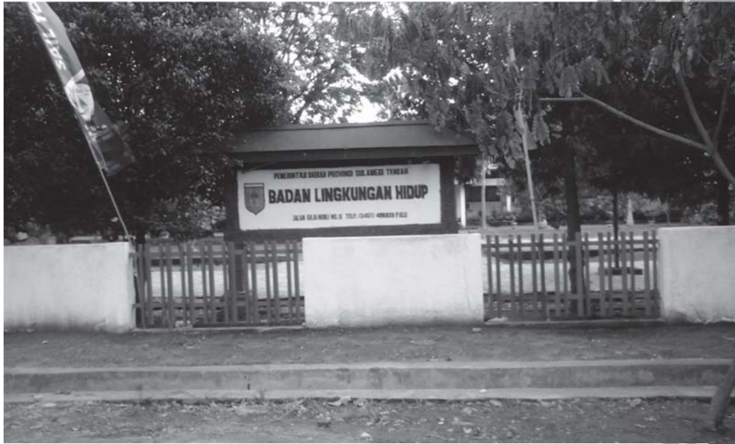
ID Bangunan B-125 Struktur Pasangan 1 Lantai, Kategori Penggunaan : Pemerintahan
