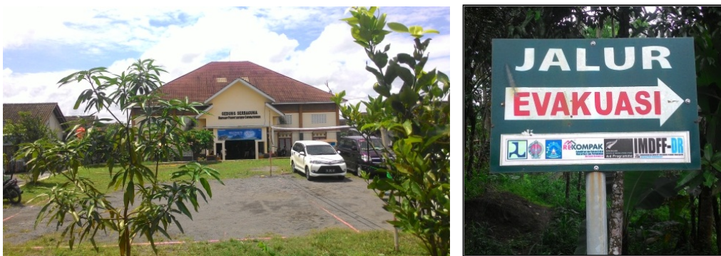
Figure A3.7 Fasilitas Gedung Serba Guna dan Papan Petunjuk Jalur Evakuasi yang Telah Disediakan oleh Pemerintah
