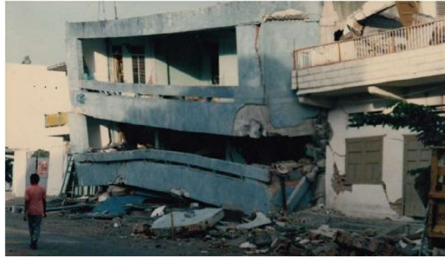
Gambar 11. Kerusakan bangunan akibat gempa 1992 di Ende (Sumber: Heryadi Rachmad, geomagz.geologi.esdm.go.id)
