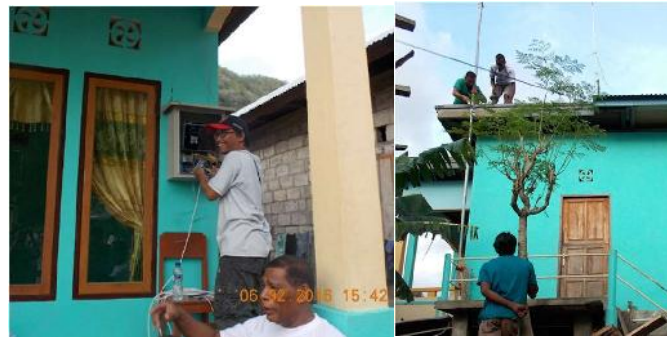
Gambar 30. Pemasangan setasiun pengendali data, pengkal petir dan antena radio komunitas siaga bencana
