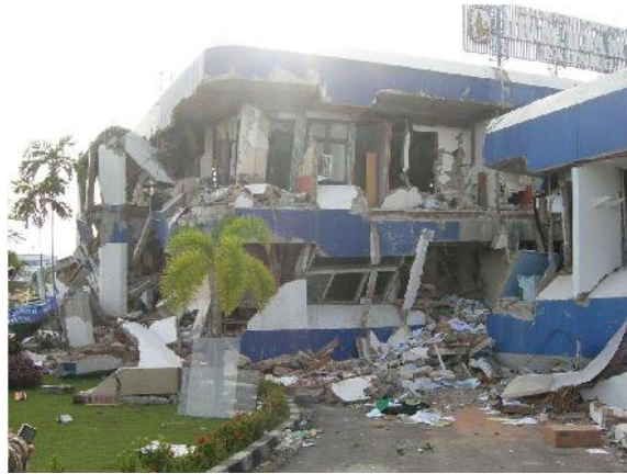
Gambar 2 Kerusakan bangunan akibat gempa Padang tahun 2009
