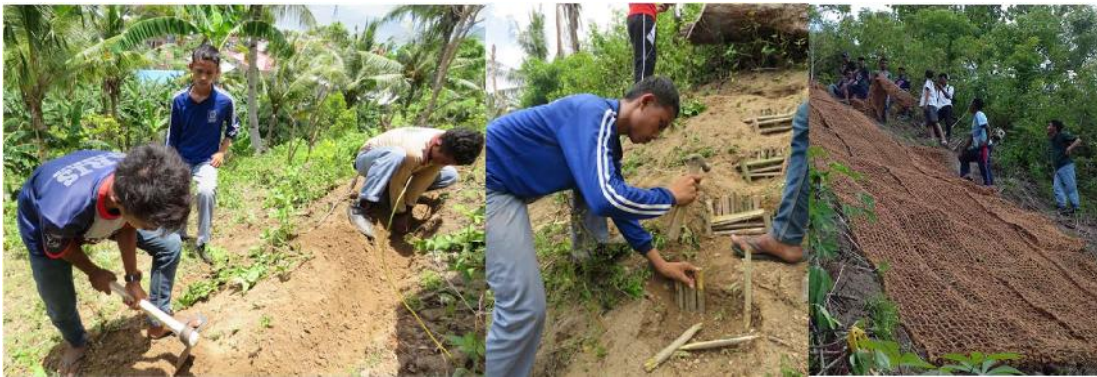
Gambar 21. Pelatihan pembuatan terasering dan pemasangan cocomesh
