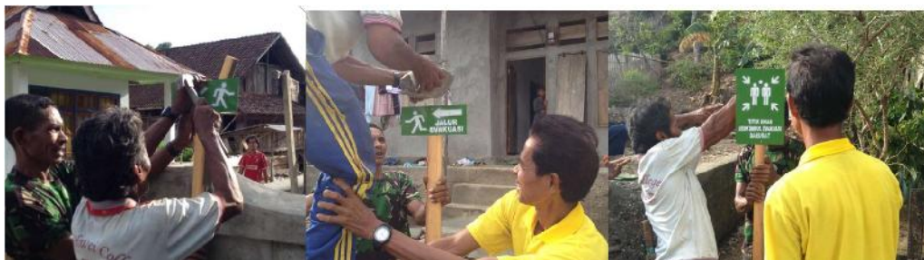
Gambar 19. Pemasangan tanda tempat dan arah evakuasi oleh tim siaga bencana Dusun Nasiri
