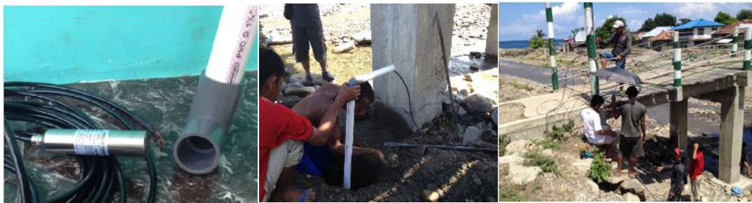
Gambar 29. Pemasangan sensor pengukur elevasi muka air
