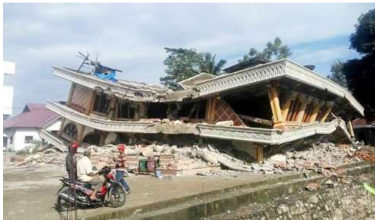
Gambar 3 Kerusakan bangunan akibat gempa Pidie Jaya tahun 2016 ( http://harianhaluan.com/mobile/detailberita/62634/gempa-aceh-2004--dan-2016-berkaitan )
